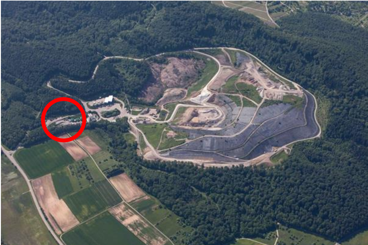
Abb. 4: Übersichtsbild der Deponie Burghof mit eingekreister Sickerwasserbehandlung.
