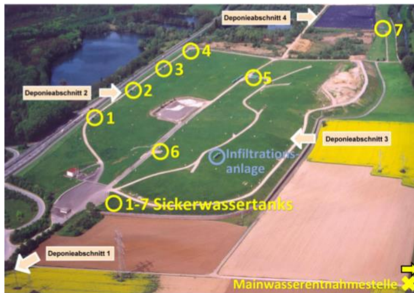
Abb. 3: Beschriftete Luftbildaufnahme des Geländes mit den einzelnen Messtellen und Deponieabschnitten.
